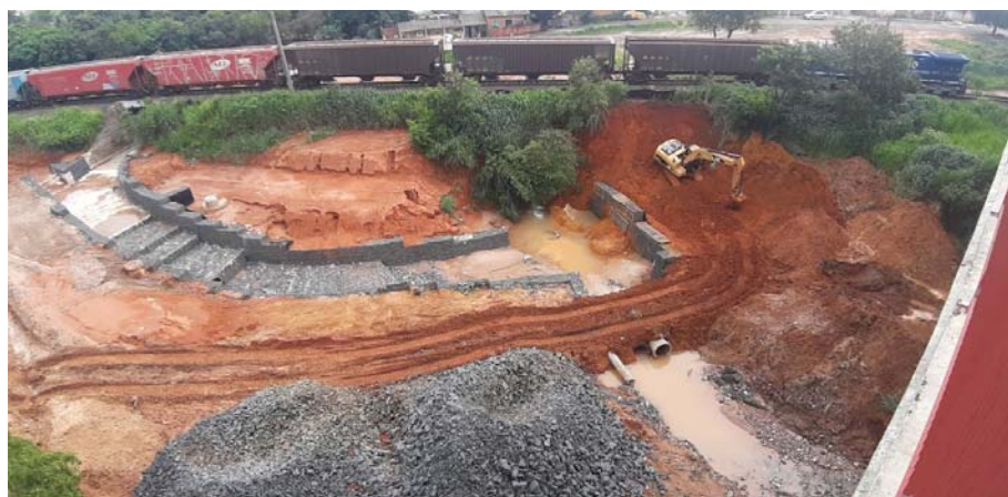
Drenagem do Córrego do Jacuba
