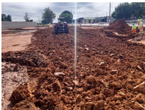
Execução do Viário – Av. Antonio da Costa Santos – Jardim Perón
