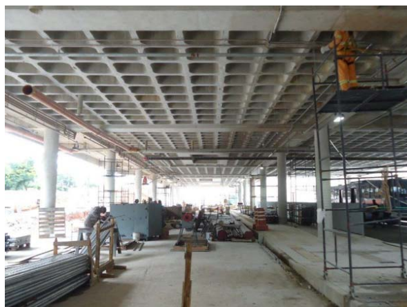
Lixamento e estucamento da laje nervurada
