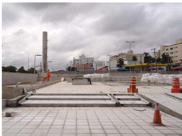
Instalação Piso do Mezanino
