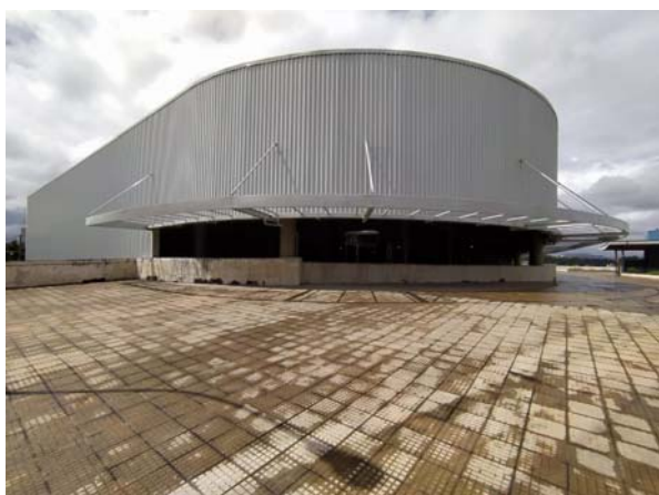
Piso Superior – Instalação das Marquises
