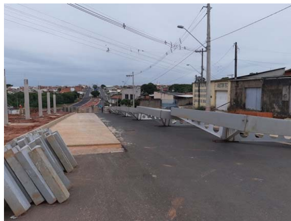
Montagem da Cobertura Metálica – Estação de Embarque e Desembarque Ataliba Nogueira
