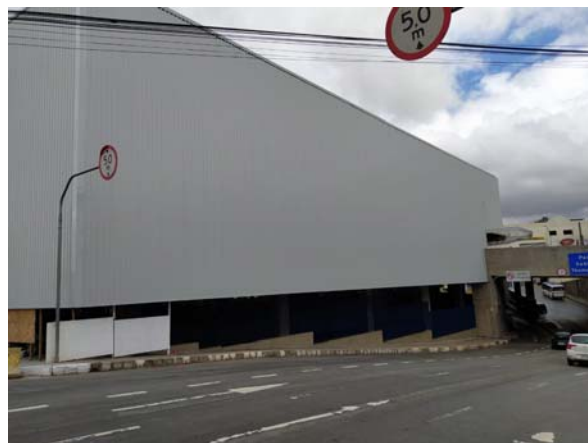
Fechamento Lateral do Terminal Sentido Osasco
