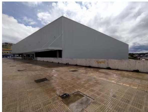
Piso Superior – Instalação das Marquises
