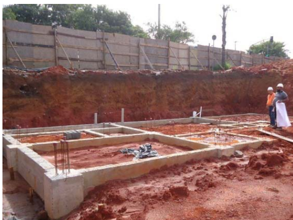
Fundação da Bilheteria e Sanitários
