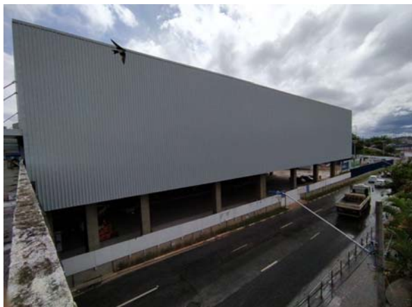
Fechamento Lateral do Terminal Sentido Itapevi
